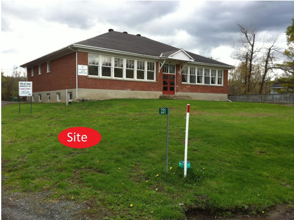
Vue à partir du Chemin de la Rivière.
