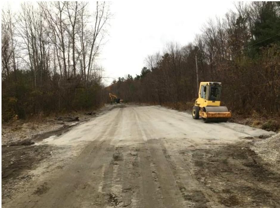
Photographie 22 – Compaction du remblai de l'excavation F7G
