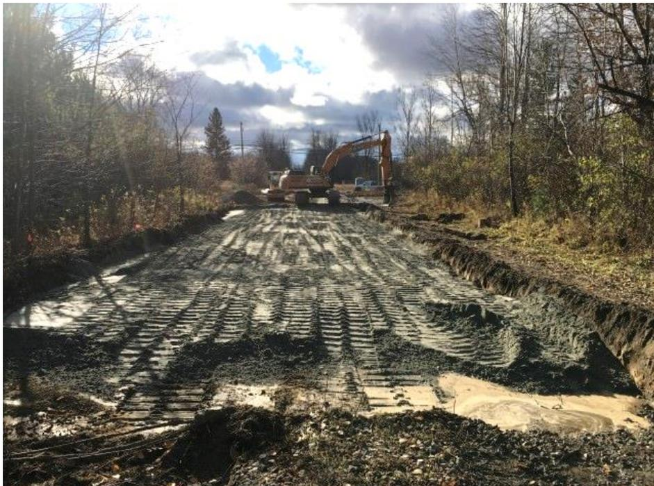
Photographie 18 – Remblai de l'excavation F12G
