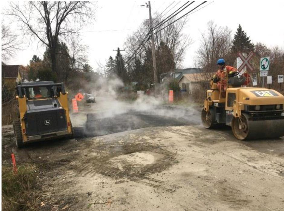
Photographie 10 – Réfection de l'asphalte du chemin Mill
