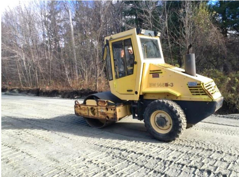
Photographie 19 – Compaction du remblai de l'excavation F12G
