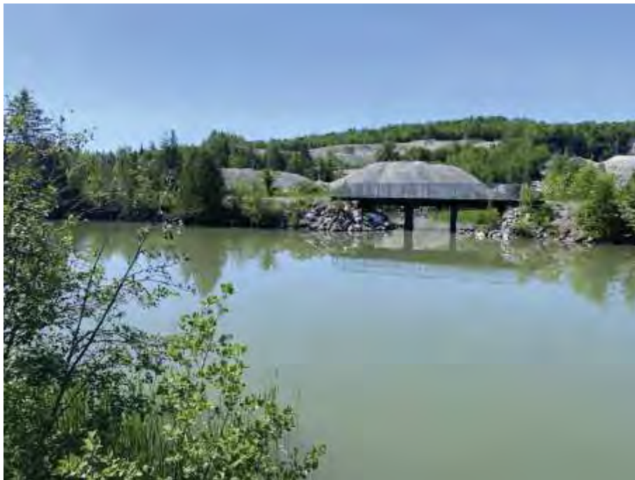
Photographie 27. Vue vers l'amont sur l'embouchure du ruisseau Meech (zone d'intervention spéciale)
