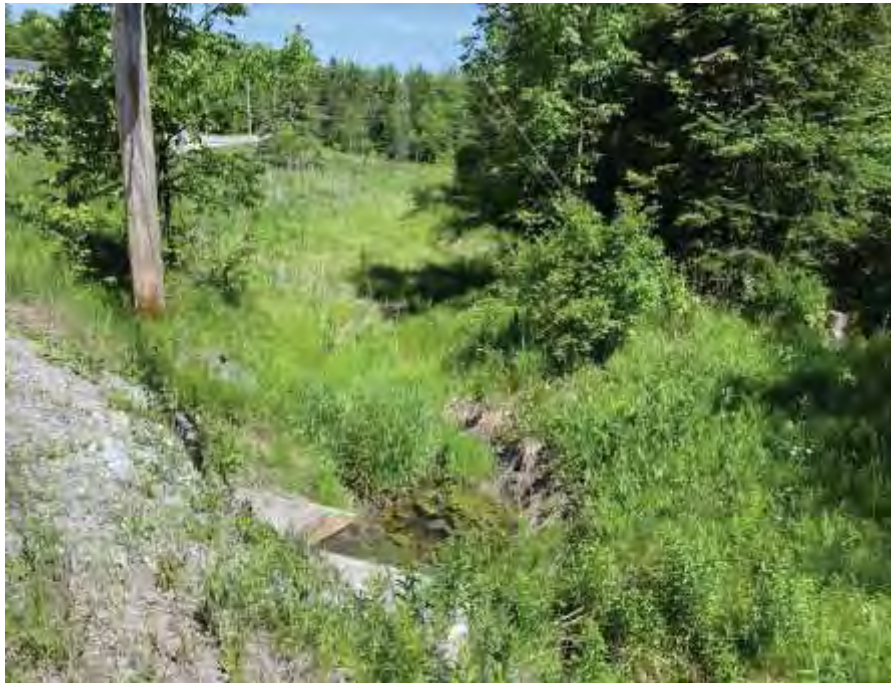
Photographie 23. Vue vers l'aval sur le cours d'eau permanent 4
