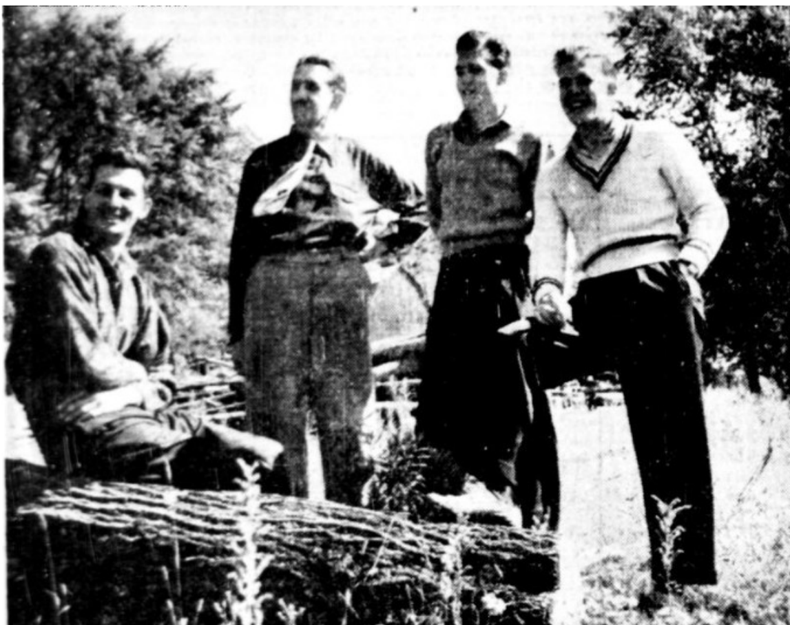
Monsieur Lyle Beamish (second en commençant de la gauche) lors des travaux du Lac Mountains en 1948 (The Ottawa Citizen, 15 Septembre 1948, page 17)
