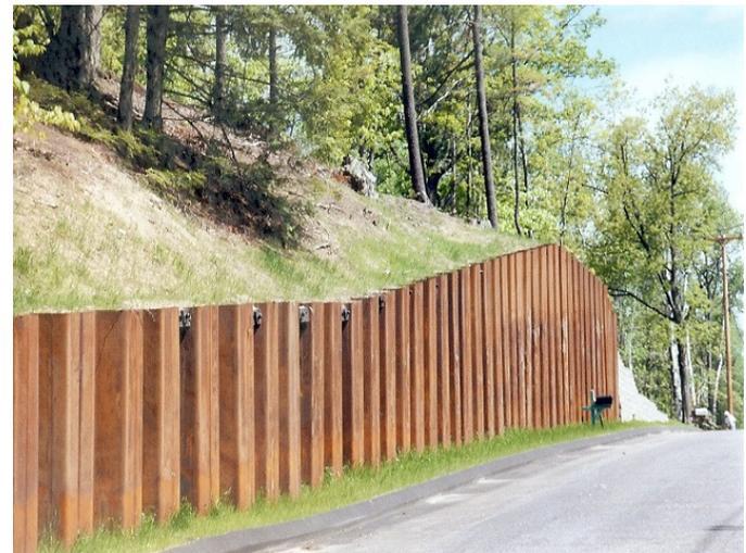
D: Mur de soutènement en palplanches
