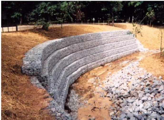
C: Mur de soutènement en gabions
