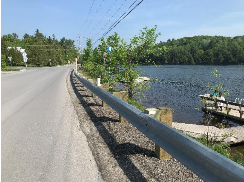
Figure 10 Présence d'un garde-fou entre la route et la zone de baignade projetée.
