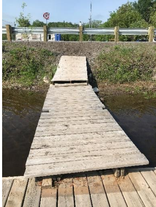
Figure 4 Passerelle pour accéder au quai
