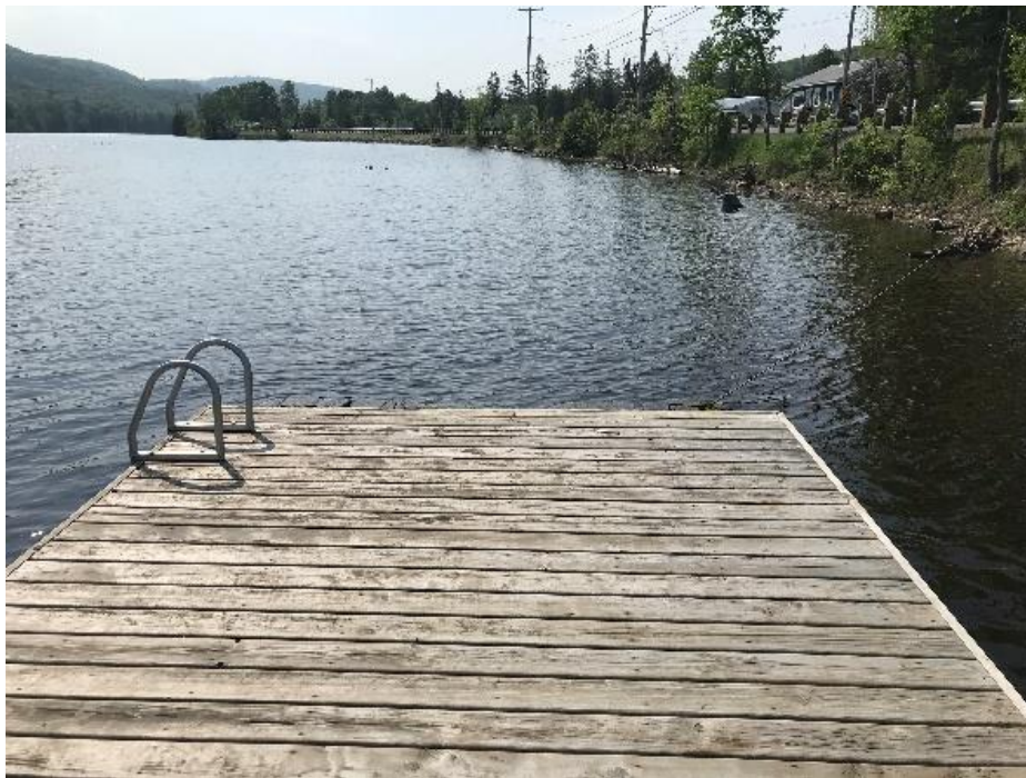
Figure 7 Échelle pour l'accès à l'eau à l'extrémité du quai. Des indications de la profondeur et d'interdiction de plongeon devront être ajoutées.
