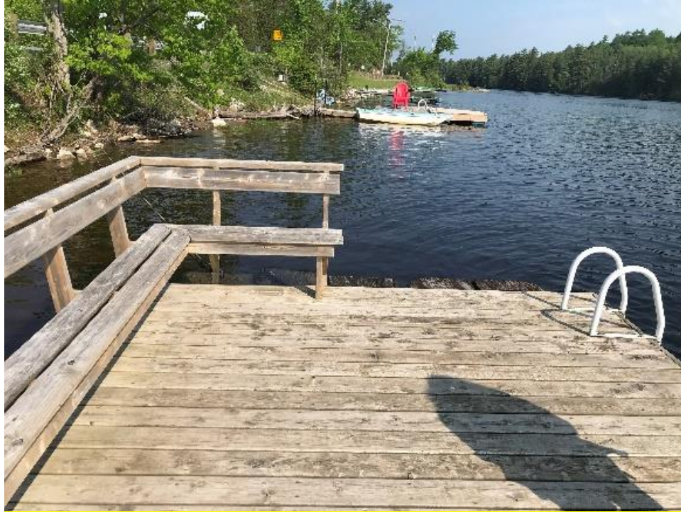
Figure 6 Quai aménagé avec un banc et une échelle à chaque extrémité pour permettre un accès sécuritaire
