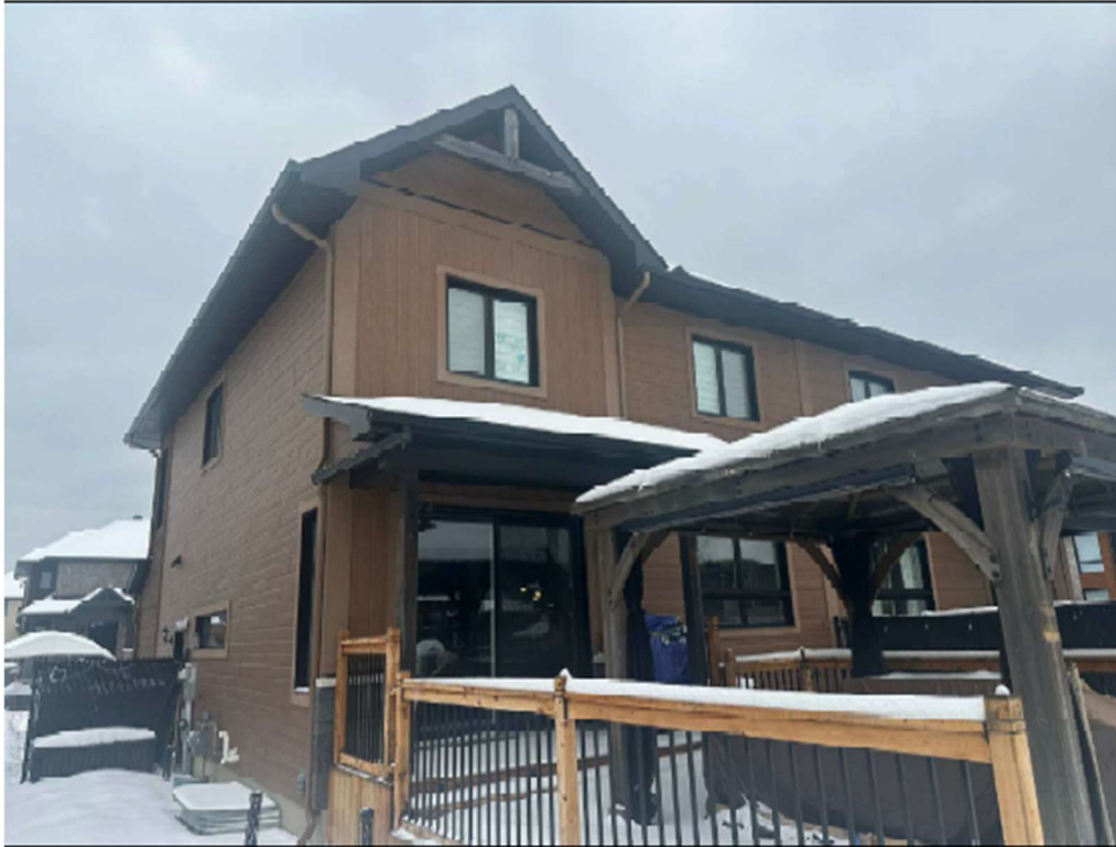
PHOTO ARRIERE DE LA MAISON EXISTANTE
