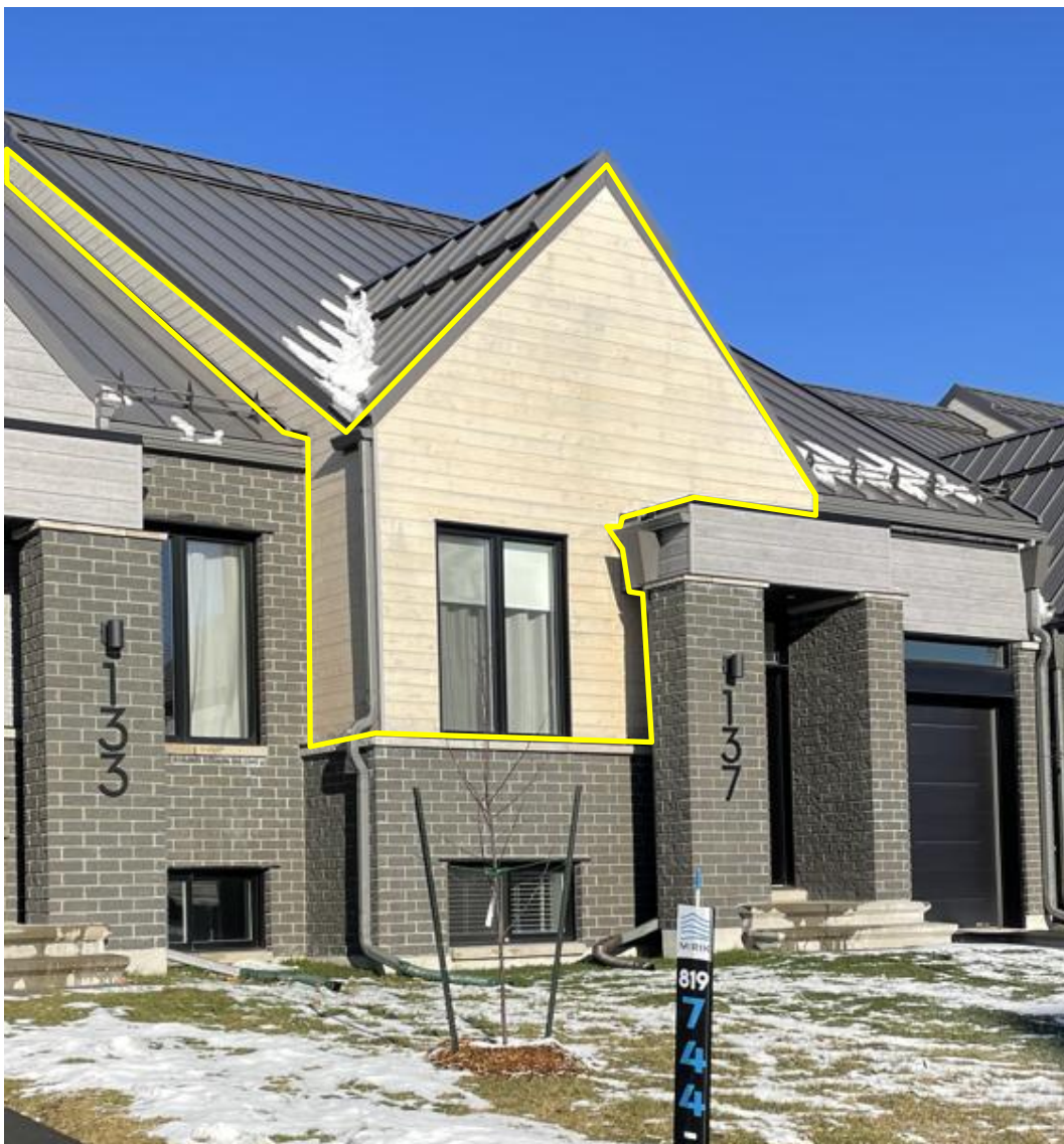
Façade avant et latérale gauche avant son grisonnement naturel
